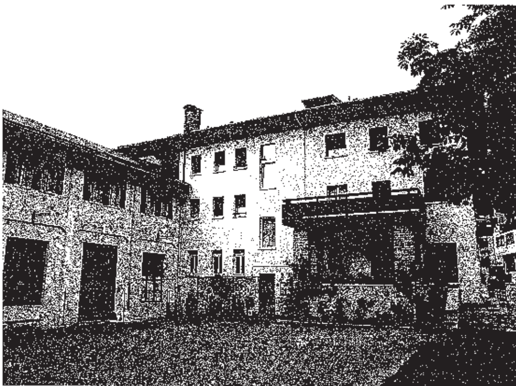
Foto 2 – Porzione del fabbricato vista est e piazzale
