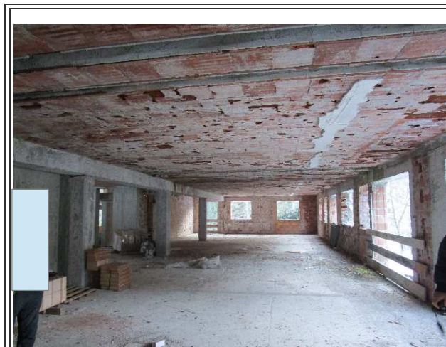
Vista zona ex camere d'albergo
