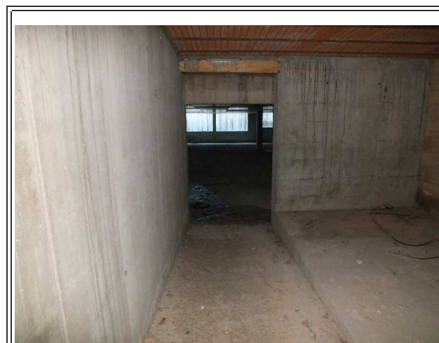
Vista rampetta di collegamento interati
