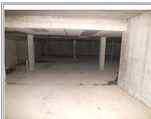
Vista rampa ingresso da sud
