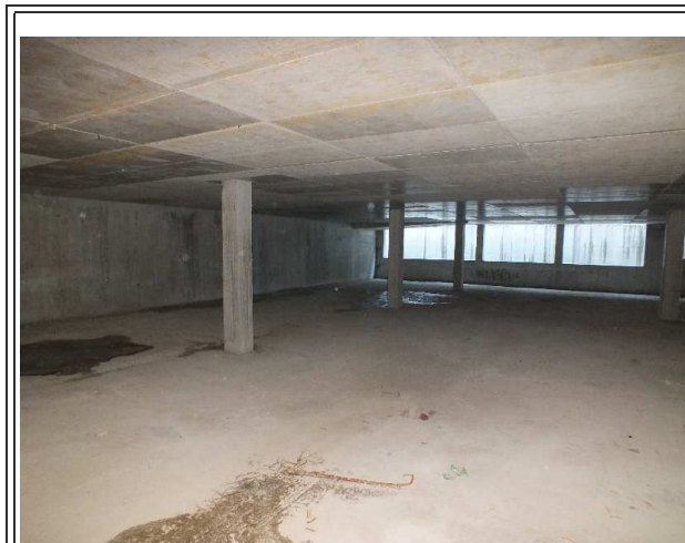
Vista interrato di nuova realizzazione
